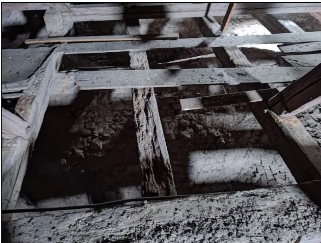
fot. 25. Oczyszczenie i impregnacja zdalnych elementów konstrukcyjnych. Wzmocnienie poprzez dokładkę oraz miejscowa wymiana elementów.
