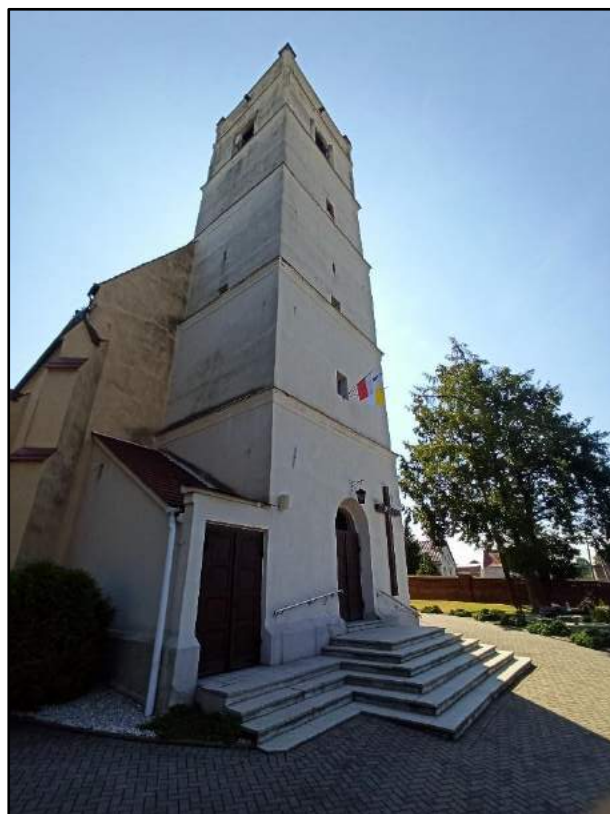
fot. 2. Widok od strony wieży
