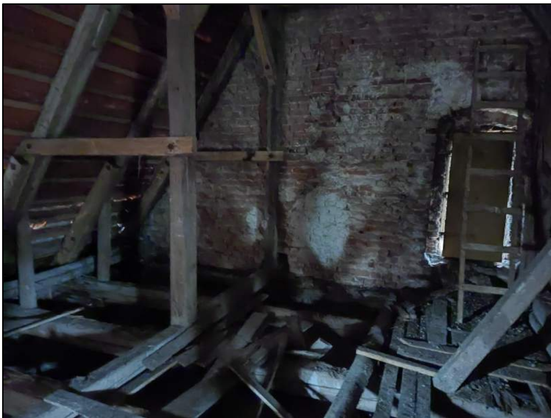
fot. 15. Oczyszczenie i impregnacja zdalnych elementów konstrukcyjnych.
