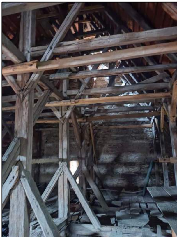
fot. 21. Oczyszczenie i impregnacja zdalnych elementów konstrukcyjnych, wymiana desek podłogowych – stworzenie podestu roboczego, wymiana spękanych belek.
