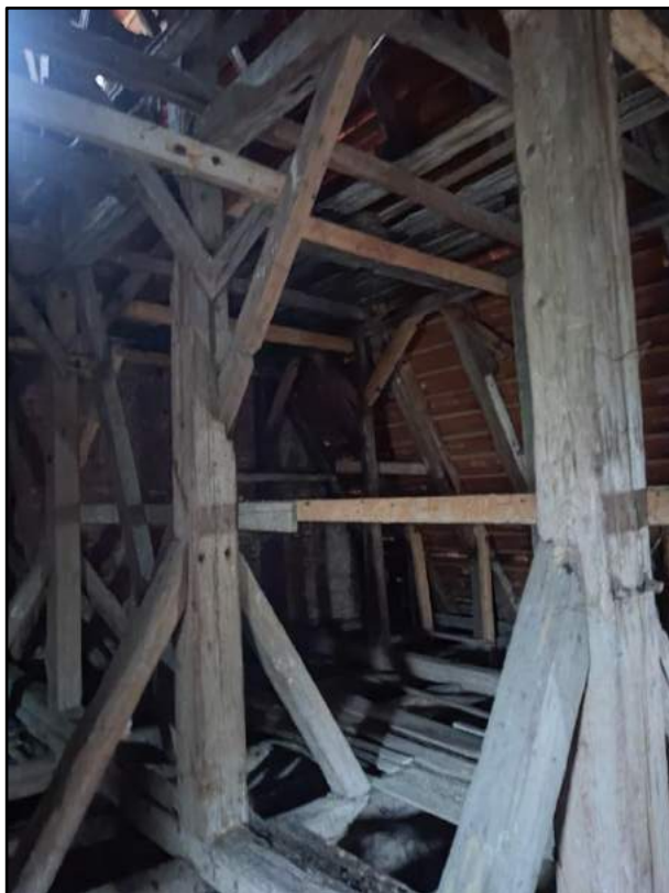
fot. 22. Oczyszczenie i impregnacja zdalnych elementów konstrukcyjnych, wymiana desek podłogowych – stworzenie podestu roboczego, wymiana spękanych belek.
