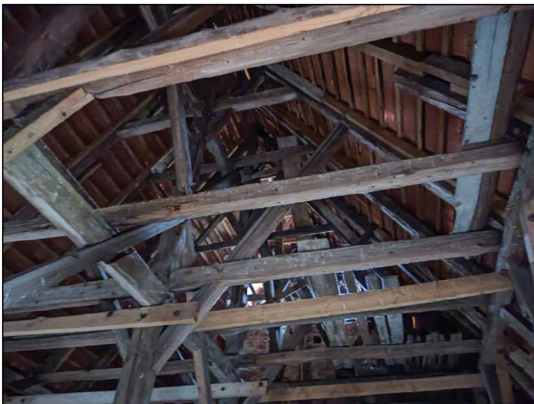
fot. 24. Oczyszczenie i impregnacja zdalnych elementów konstrukcyjnych.
