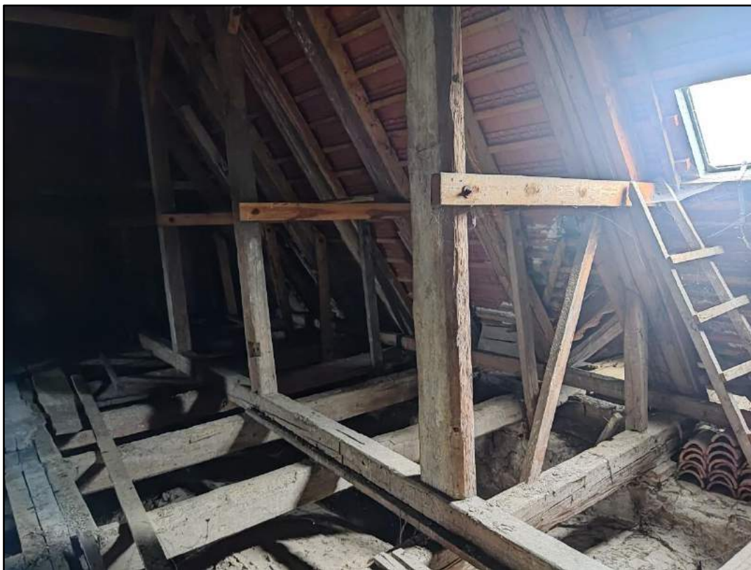
fot. 13. Oczyszczenie i impregnacja zdalnych elementów konstrukcyjnych.
