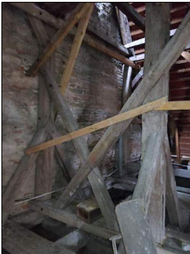
fot. 11. Oczyszczenie i impregnacja zdalnych elementów konstrukcyjnych.
