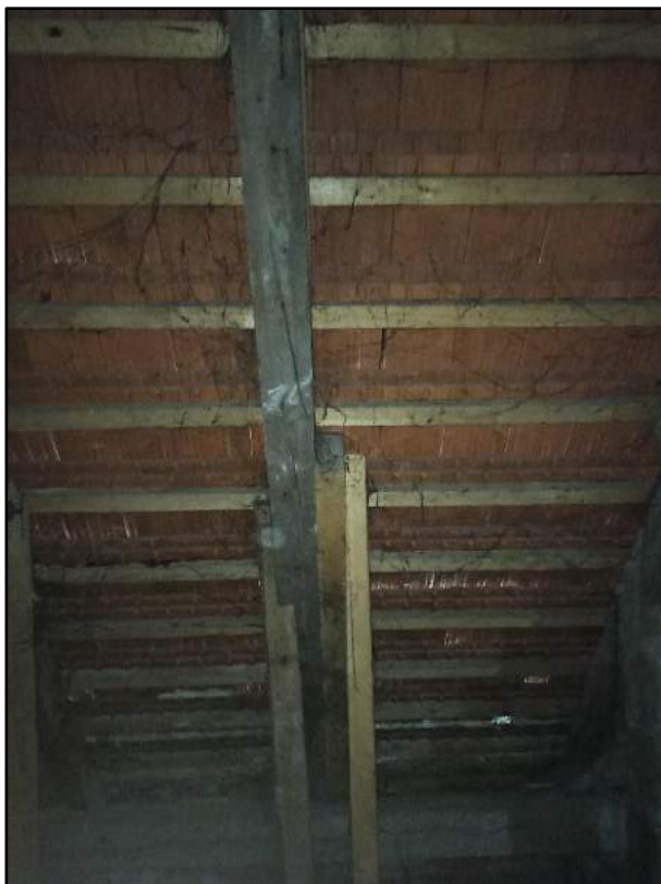
fot. 31. Aktualne wzmocnienie krokwi, oczyszczenie oraz impregnacja zdalnych elementów konstrukcyjnych.
