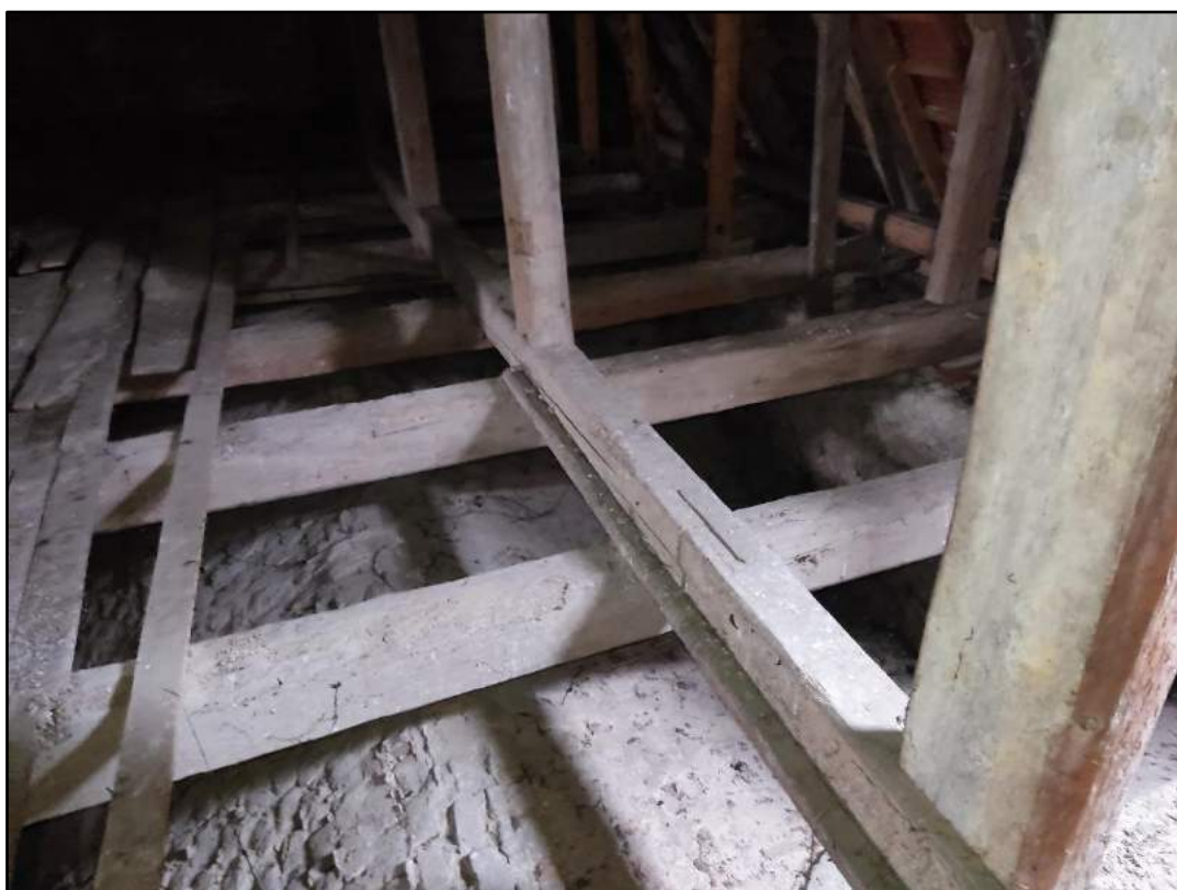
fot. 40. Oczyszczenie i impregnacja zdanych elementów konstrukcyjnych, wymiana desek podłogowych – stworzenie podestu roboczego, wymiana spękanych belek..
