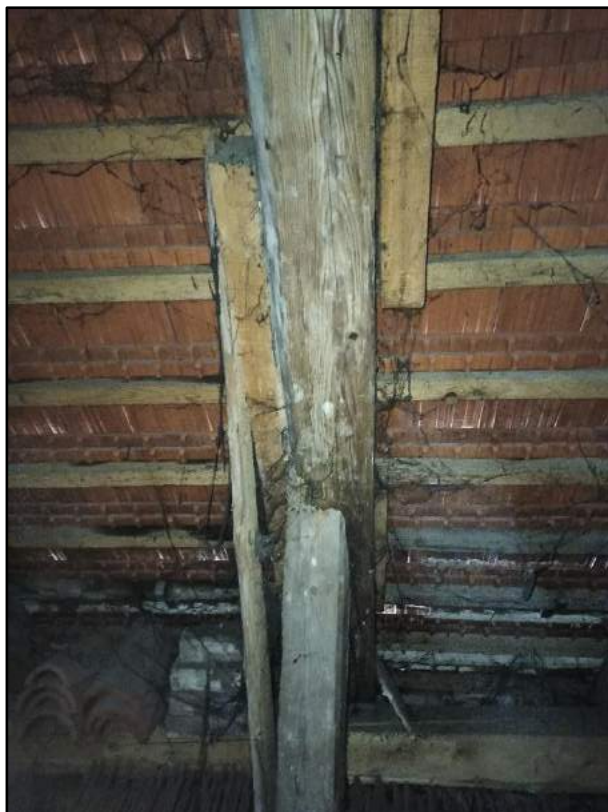
fot. 29. Aktualne wzmocnienie krokwi, oczyszczenie oraz impregnacja zdalnych elementów konstrukcyjnych.
