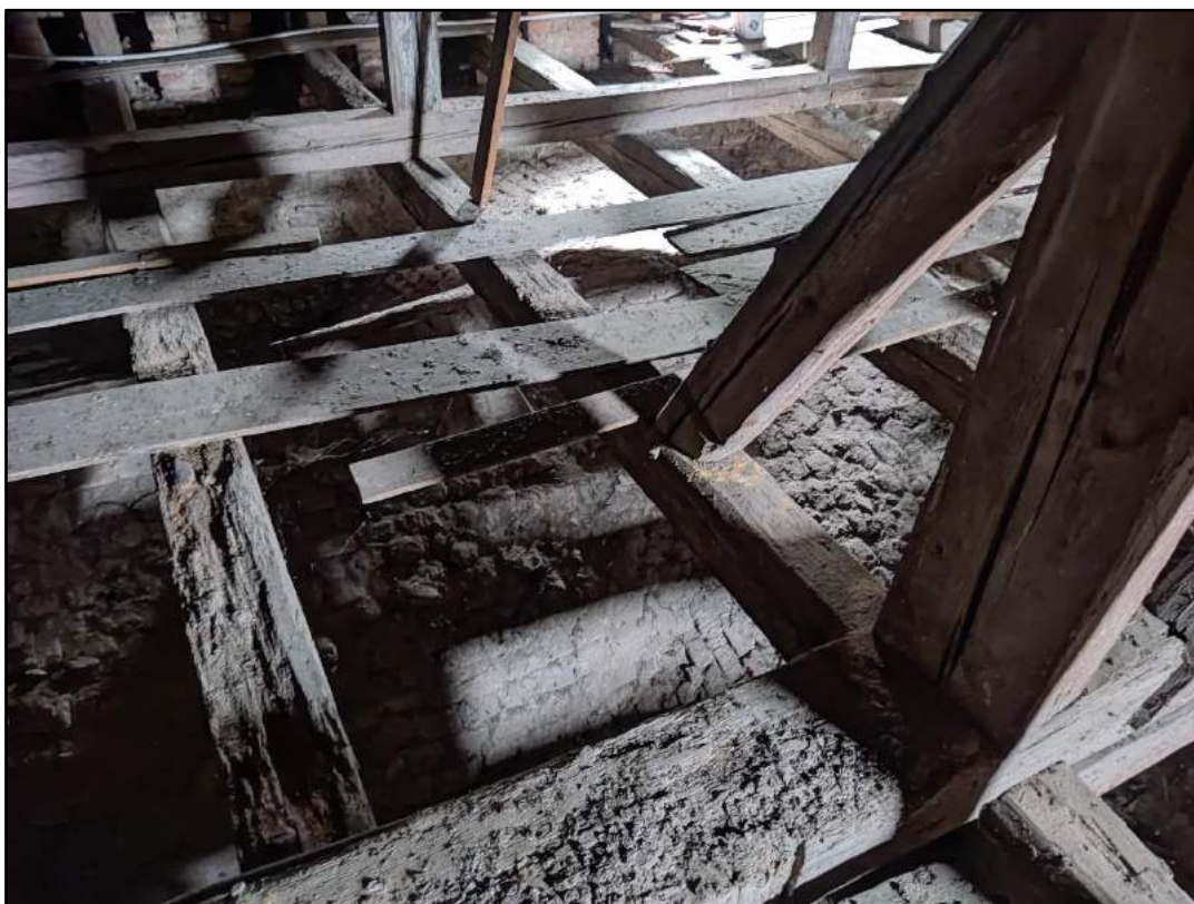
fot. 26. Oczyszczenie i impregnacja zdalnych elementów konstrukcyjnych. Wzmocnienie poprzez dokładkę oraz miejscowa wymiana elementów.
