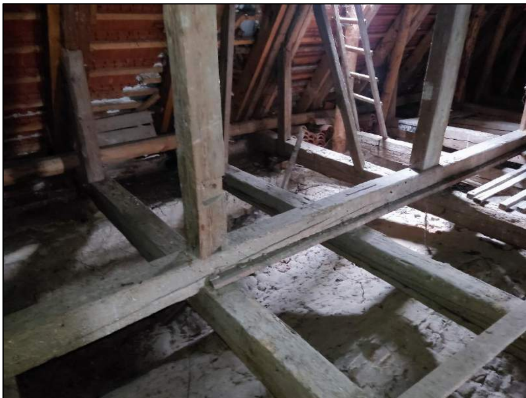
fot. 39. Oczyszczenie i impregnacja zdanych elementów konstrukcyjnych.
