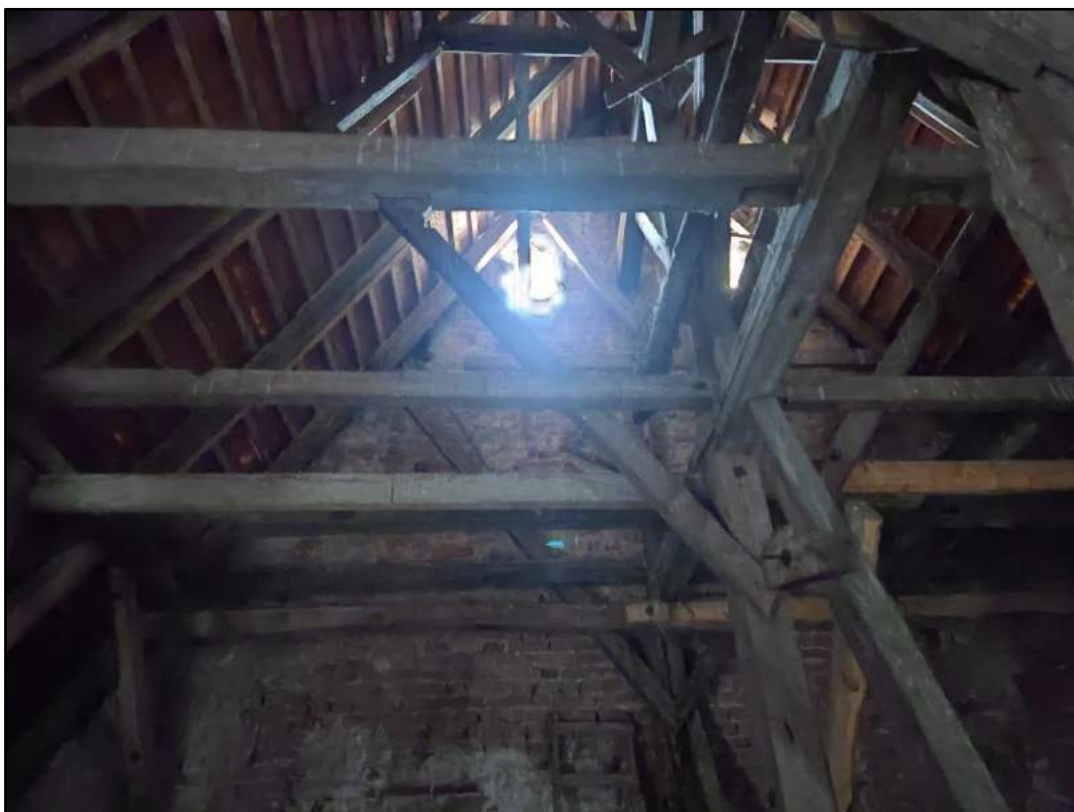
fot. 16. Oczyszczenie i impregnacja zdalnych elementów konstrukcyjnych.
