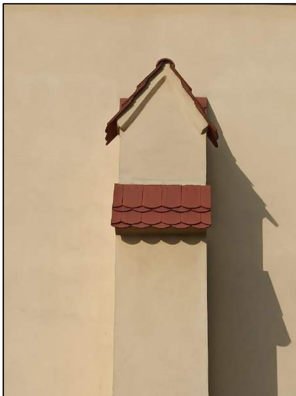
fot. 9. Detal przypory – krycie dachówką karpiówką układaną w koronkę
