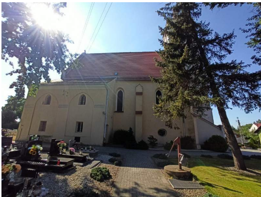
fot. 7. Widok od strony północnej
