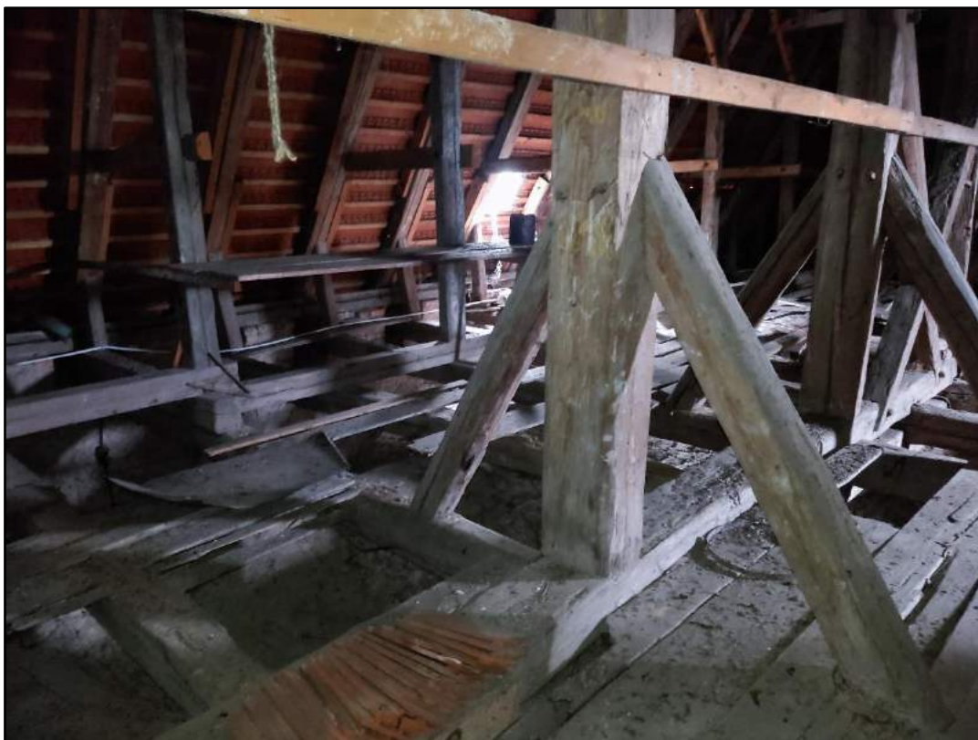
fot. 36. Oczyszczenie i impregnacja zdatnych elementów konstrukcyjnych.
