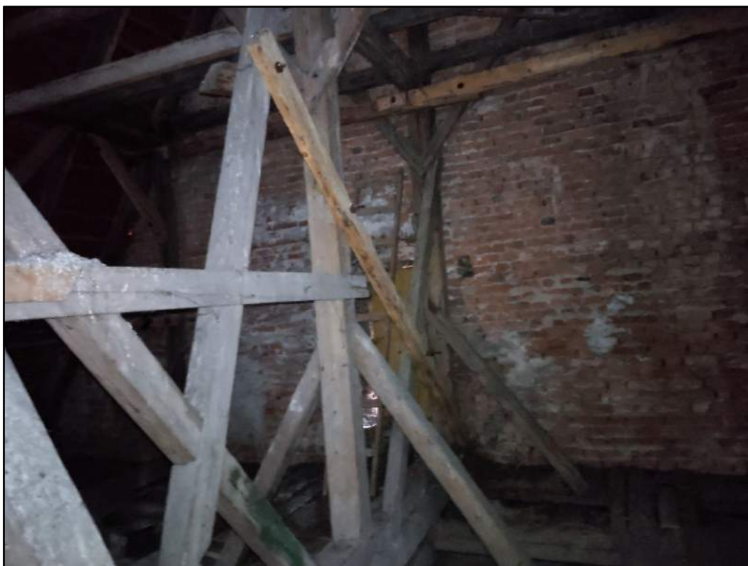
fot. 38. Oczyszczenie i impregnacja zdanych elementów konstrukcyjnych.
