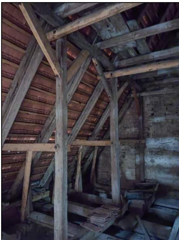
fot. 12. Oczyszczenie i impregnacja zdalnych elementów konstrukcyjnych.
