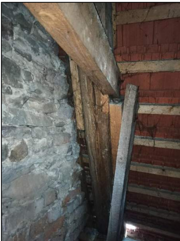
fot. 32. Aktualne wzmocnienie krokwi, oczyszczenie oraz impregnacja zdalnych elementów konstrukcyjnych.
