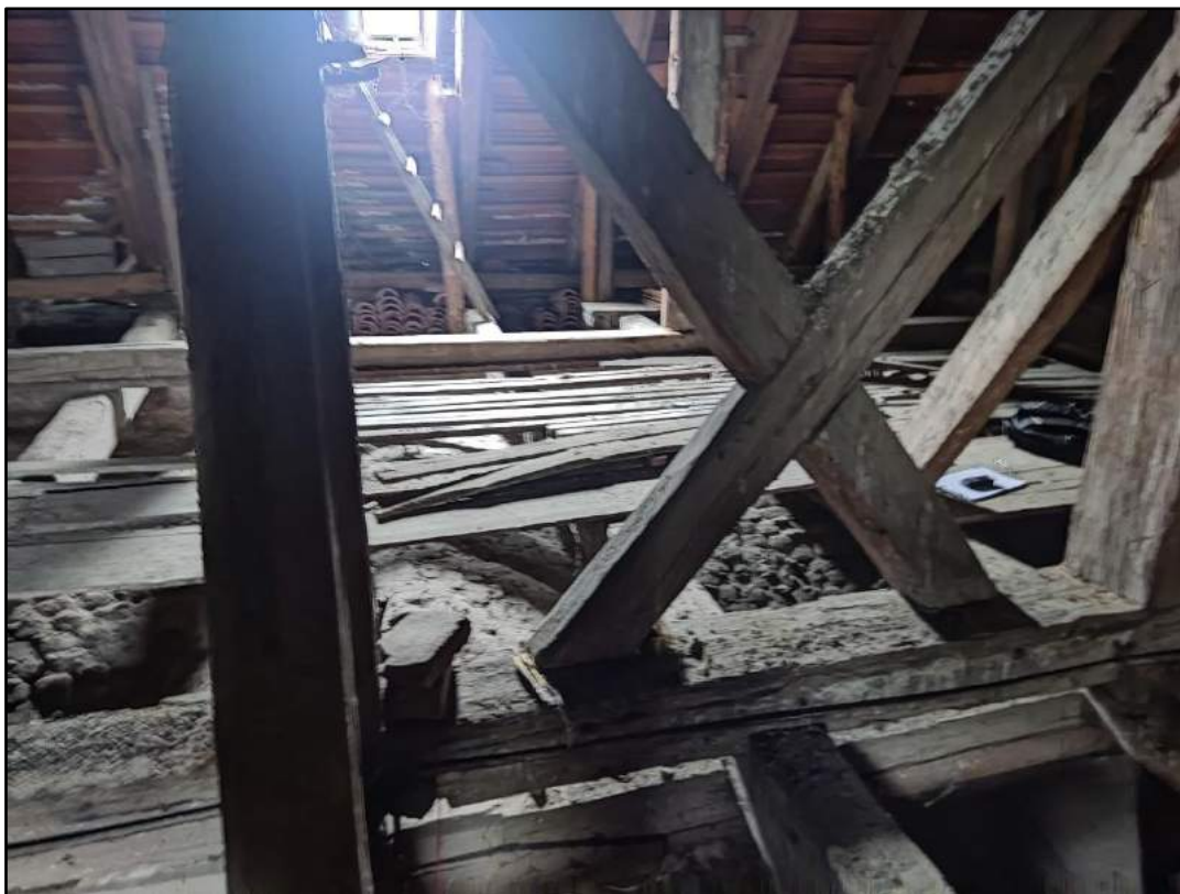
fot. 23. Oczyszczenie i impregnacja zdalnych elementów konstrukcyjnych, wymiana desek podłogowych – stworzenie podestu roboczego, wymiana spękanych belek.
