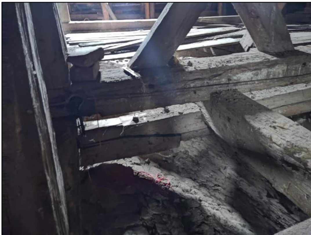
fot. 33. Częściowa wymiana zbutwiałych belek, oczyszczenie oraz impregnacja zdalnych elementów konstrukcyjnych.
