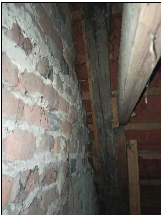
fot. 30. Aktualne wzmocnienie krokwi, oczyszczenie oraz impregnacja zdalnych elementów konstrukcyjnych.
