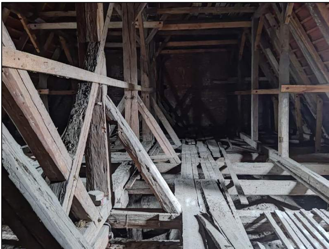
fot. 27. Oczyszczenie i impregnacja zdalnych elementów konstrukcyjnych. Wzmocnienie poprzez dokładkę oraz miejscowa wymiana elementów.
