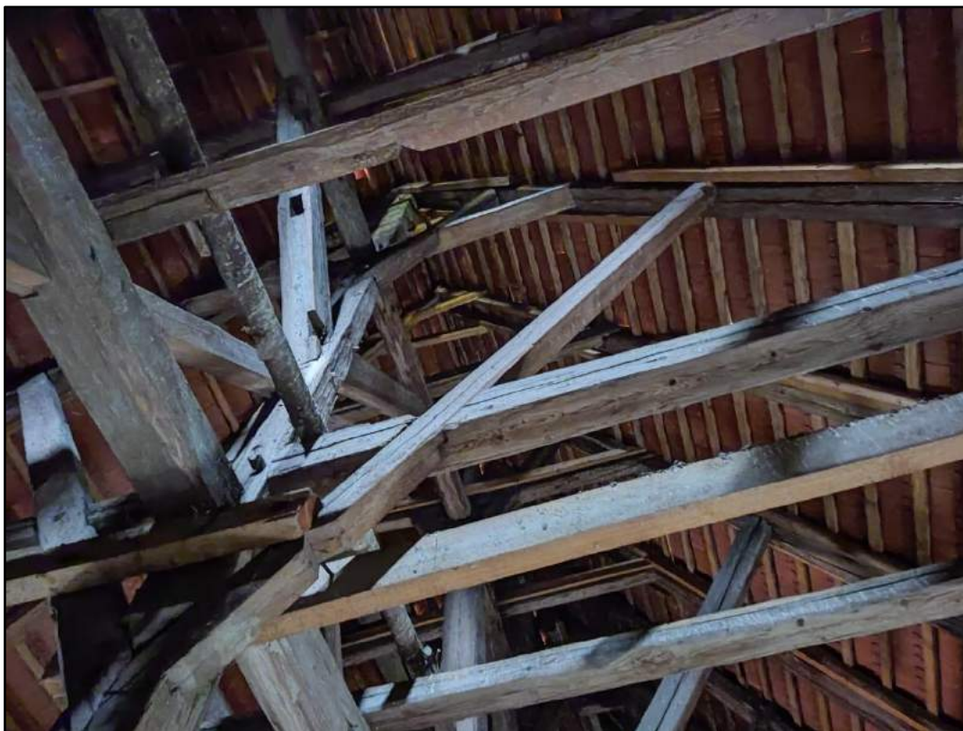
fot. 19. Oczyszczenie i impregnacja zdanych elementów konstrukcyjnych.
