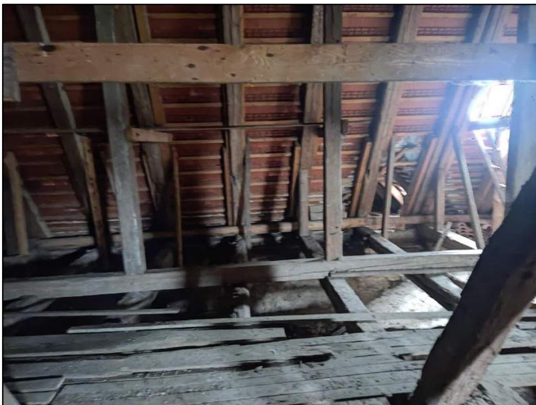
fot. 18. Oczyszczenie i impregnacja zdalnych elementów konstrukcyjnych, wymiana desek podłogowych – stworzenie podestu roboczego.
