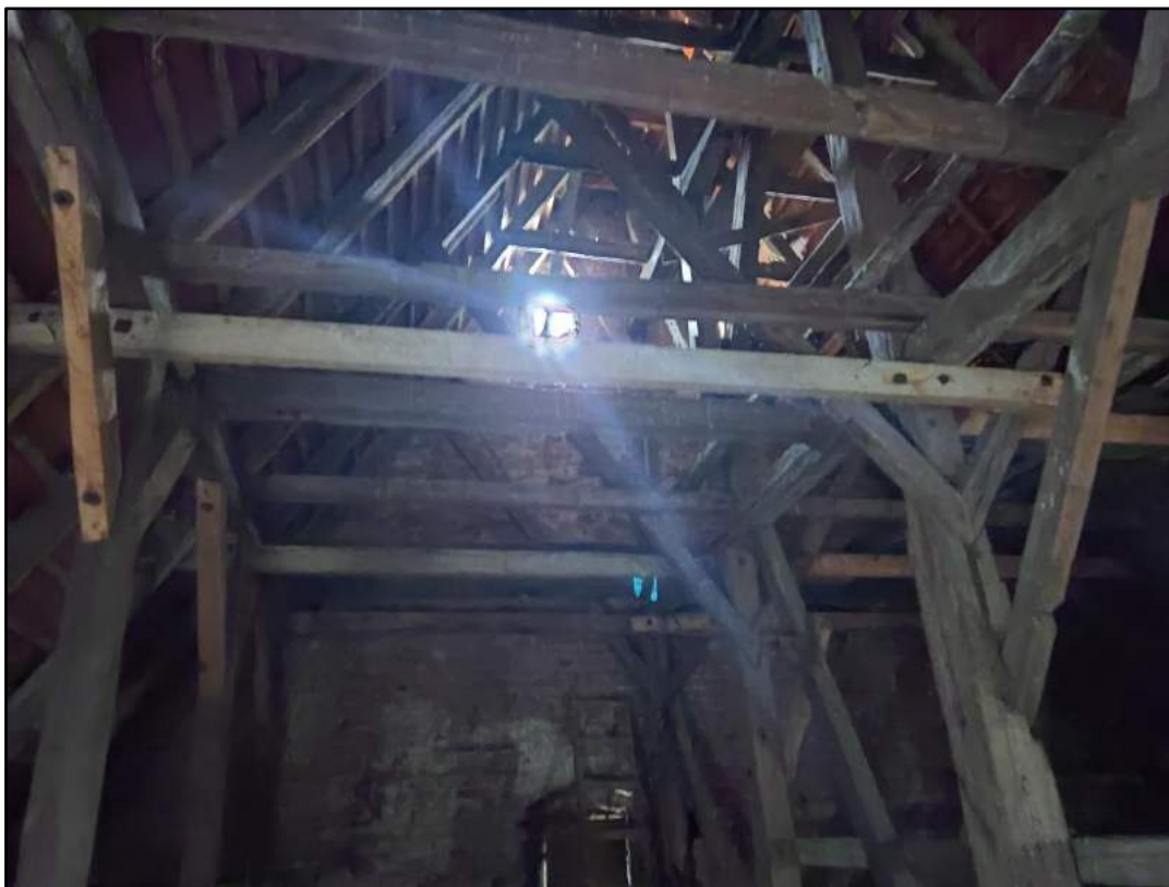
fot. 37. Oczyszczenie i impregnacja zdanych elementów konstrukcyjnych.
