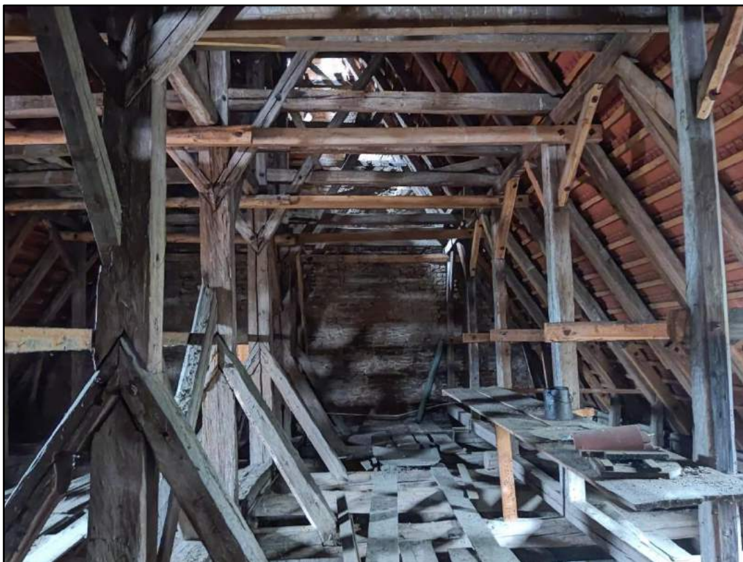
fot. 17. Oczyszczenie i impregnacja zdalnych elementów konstrukcyjnych, wymiana desek podłogowych – stworzenie podestu roboczego.
