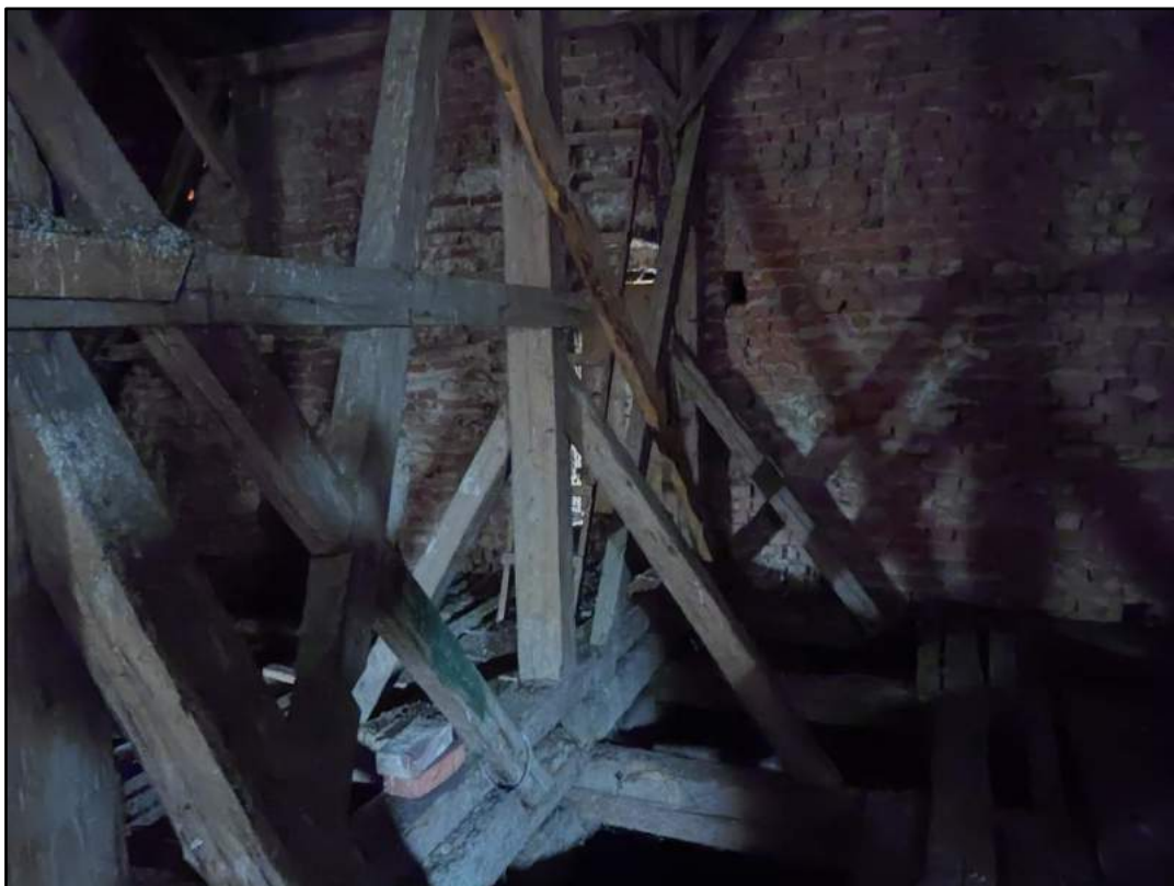
fot. 14. Oczyszczenie i impregnacja zdalnych elementów konstrukcyjnych.
