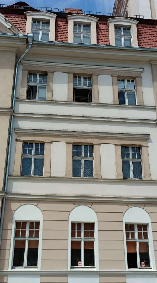
Stan istniejącej stolarki okiennej
